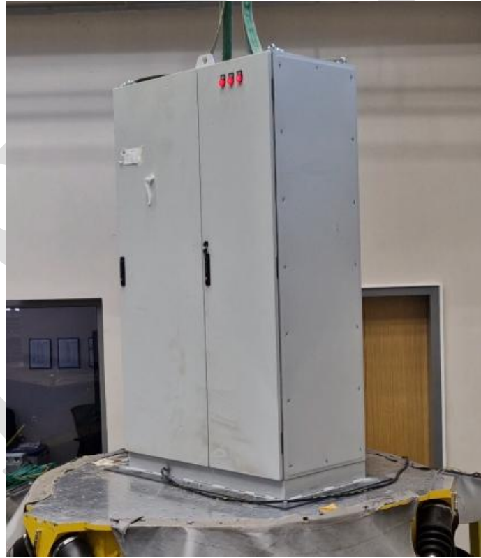
Resim 7. Test sırasında UUT çalışır halde
