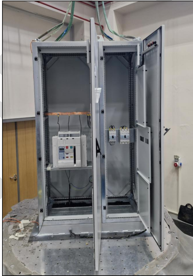
Resim 9. Kapılar açık görünüş
