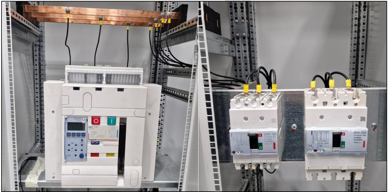
Resim 5. Devre kesici detayları
